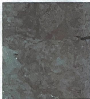
а) до заполнения пустот
